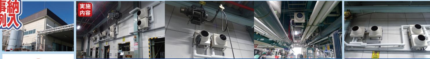
天井クレーンの妨げにならないように室内ユニットの設置場所を検証、フレックスエアーだから実現する自由度が高い設置性 狙ったエリアを効率的に空調
