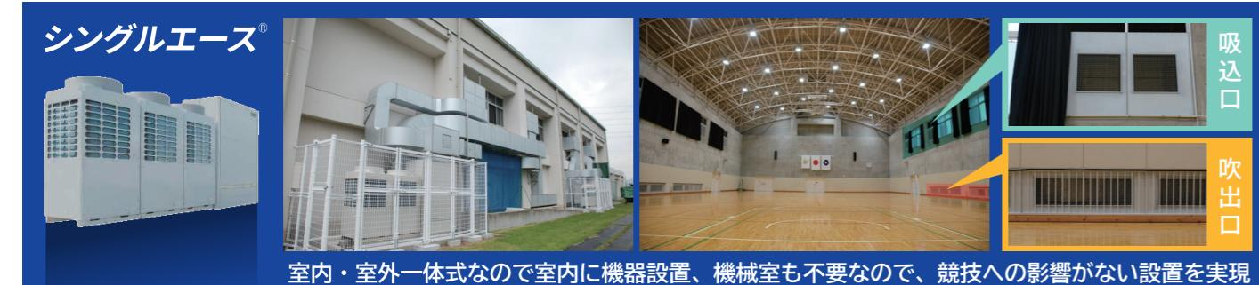
室内・室外一体式なので室内に機器設置、機械室も不要なので、競技への影響がない設置を実現
