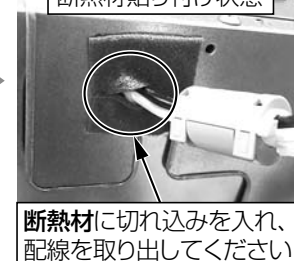
断熱材貼り付け状態
